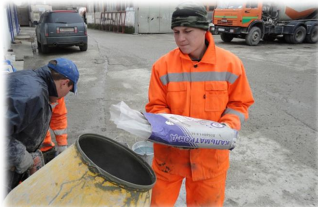
Рис. 3 – Введение добавки КАЛЬМАТРОН-Д в миксер
