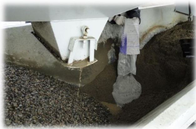
Рис. 2 – Введение добавки КАЛЬМАТРОН-Д в условиях бетонного завода (РБУ)
