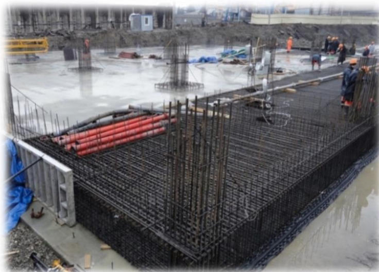
Рис. 1 – Укладка бетонной смеси с добавкой КАЛЬМАТРОН-Д
