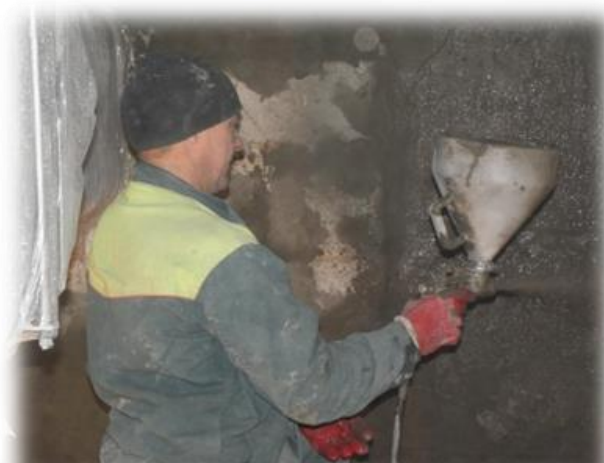
Рис. 7 – Нанесение состава КАЛЬМАТРОН механическим способом
