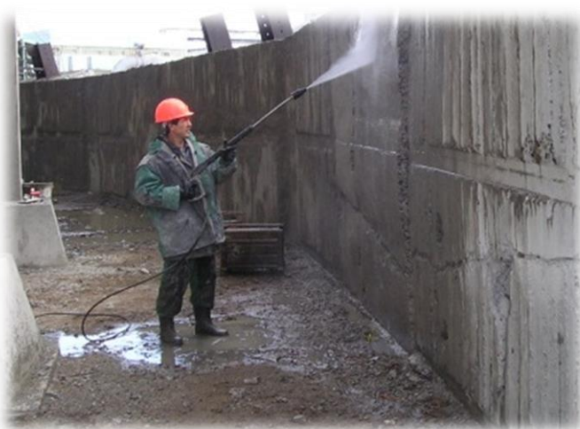
Рис. 4 – Очистение и увлажнение поверхности гидромонитором
