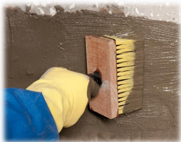
Рис. 6 – Нанесение состава КАЛЬМАТРОН кистью-макловицей
