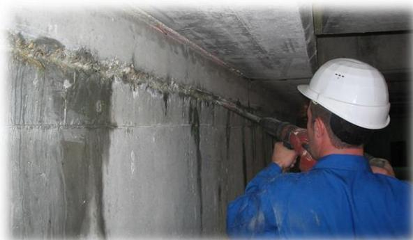
Рис. 2.2.1 Расшивка перфоратором «холодного шва бетонирования»
