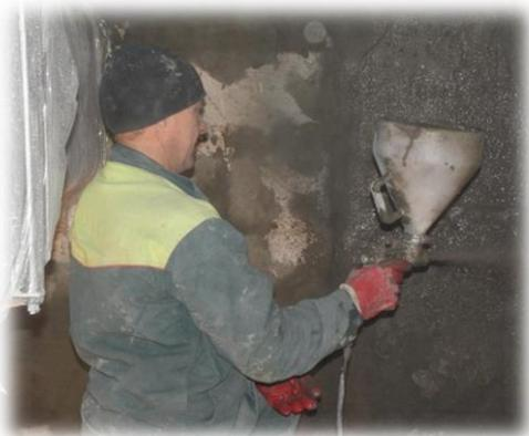
Рис. 2.2.4 Механический способ нанесения состава КАЛЬМАТРОН
