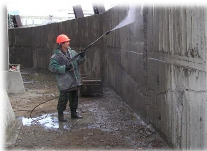
**Рис. 2.2.1 Очистка и увлажнение поверхности гидромонитором**
