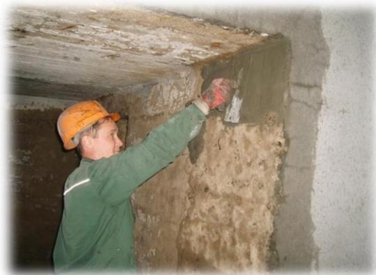
Рис. 2.2.5 Ручной способ нанесения состава КАЛЬМАТРОН
